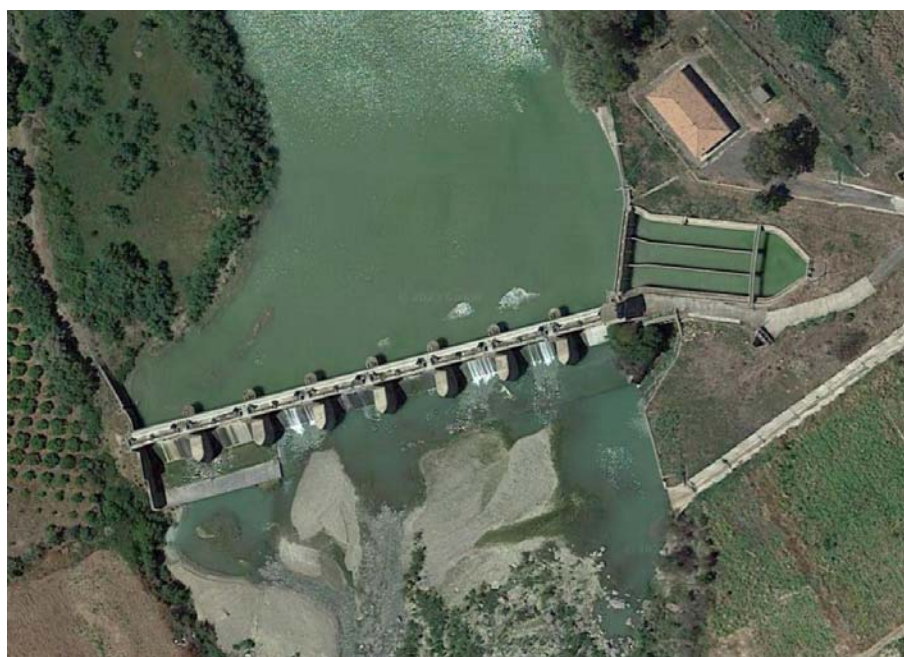
Figura 5: Foto aerea della Traversa Contrasto.
