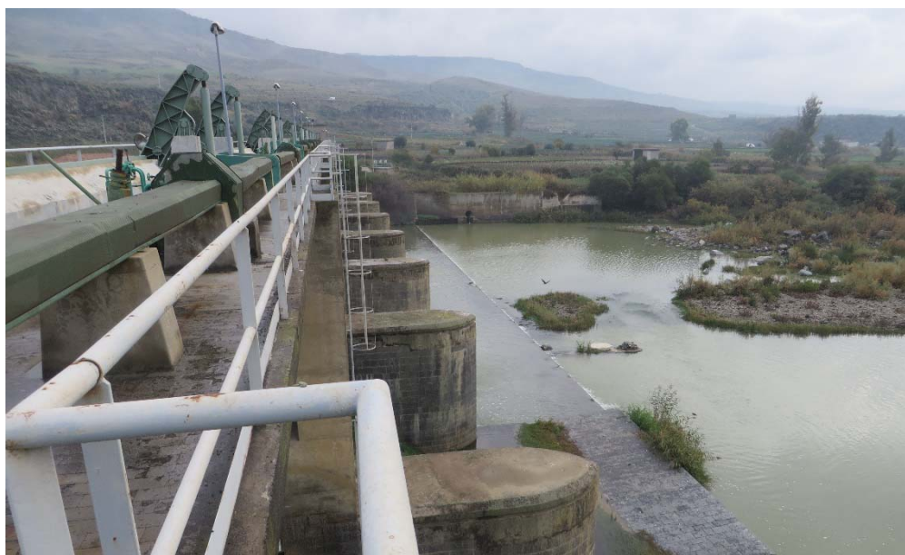
Foto 7: Particolare vista verso monte.
