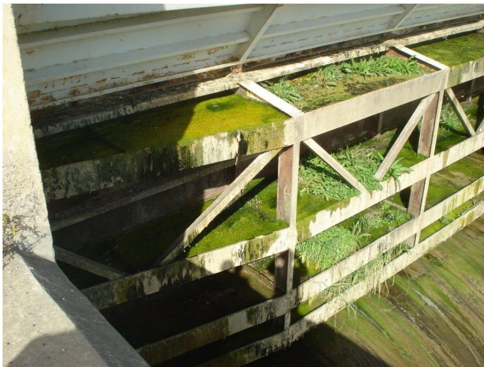
Foto 4: Paratoia 3 lato valle.
