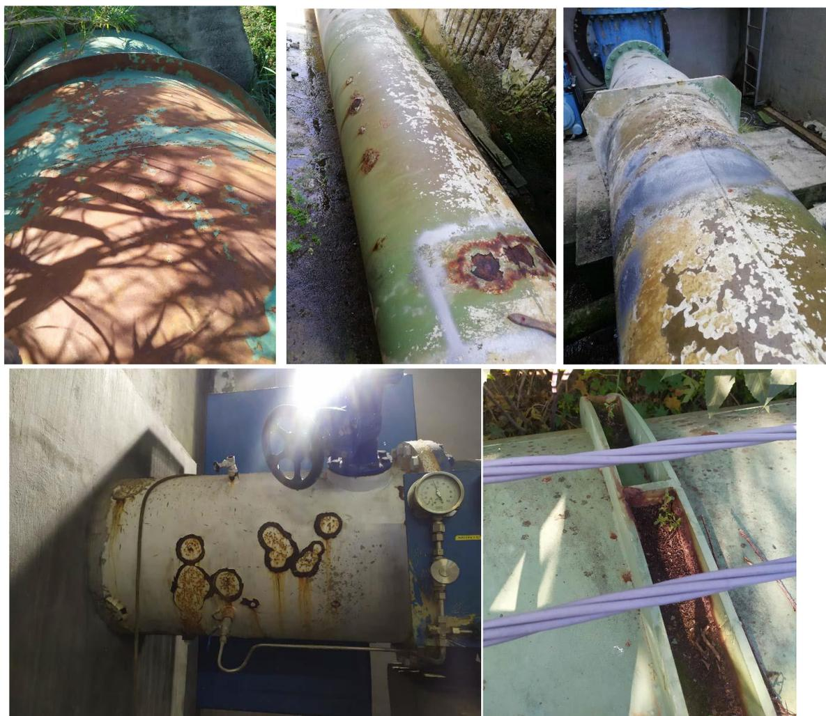
**Figura 8 - Foto dello stato d'uso attuale delle condotte**
