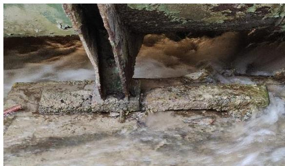
**Figura 10 -Riparazioni interna -esterna con fasce calandrate saldate**
