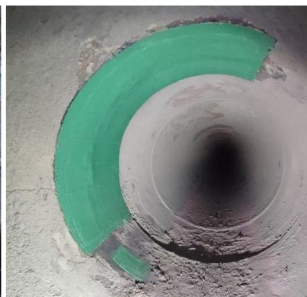
**Figura 11 -Riparazione interna-esterna con resina vetro-carbonio**
