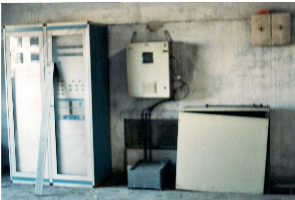
FOTO 21 : Armadio automazione in cabina elettrica
