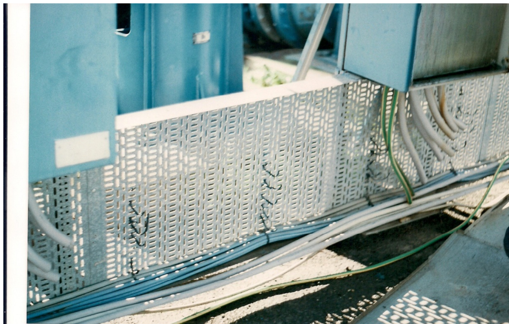
FOTO 14 : Particolare 2 distribuzione linee per gruppo elettropompe
