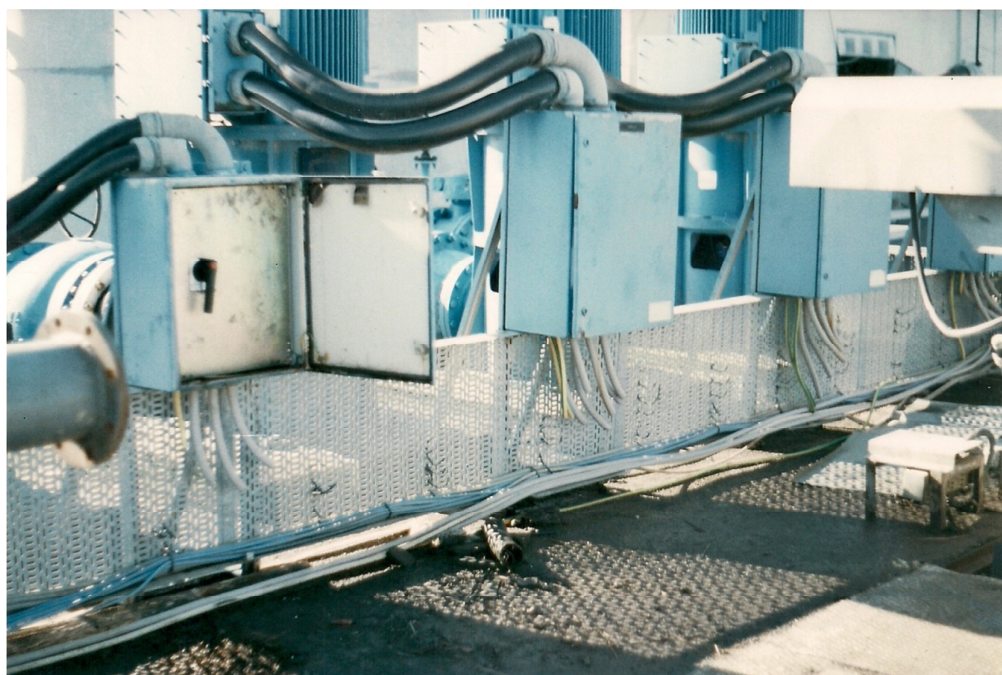
FOTO 13 : Particolare 1 distribuzione linee per gruppo elettropompe
