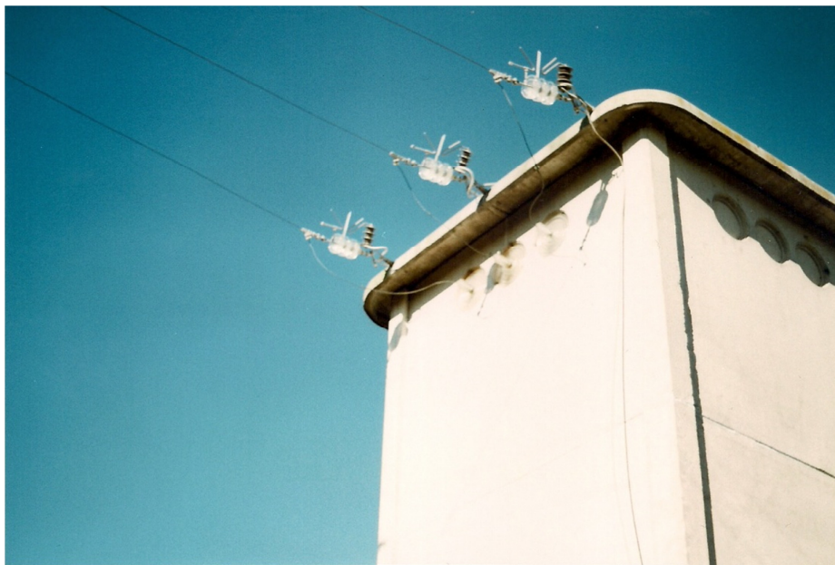
FOTO 1 : Arrivo linea MT, per cabina elettrica, in scomparto distributore di energia
