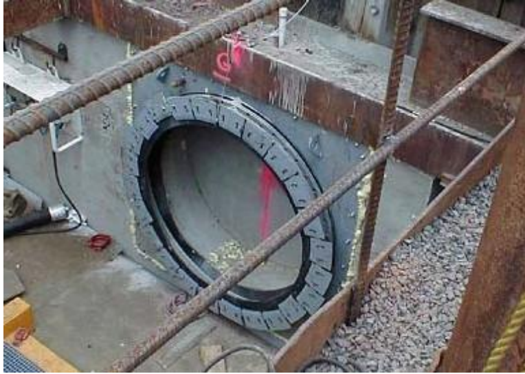
Immagine di una stazione intermedia di spinta (da Herrenknecht website)
