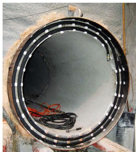
Anello ripartitore della spinta – Immagine del giunto idraulico Jackcontrol
