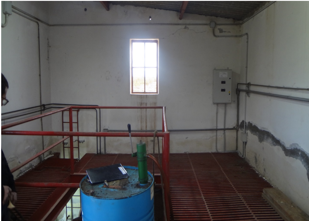
Vista interna locale biforcazione esistente
