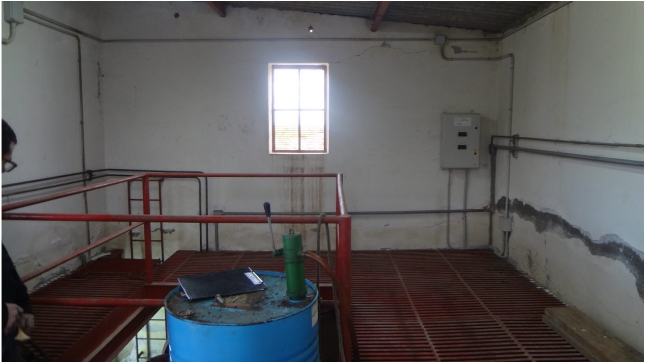
Figura 7.- Interno locale biforcazione esistente, piano terra
