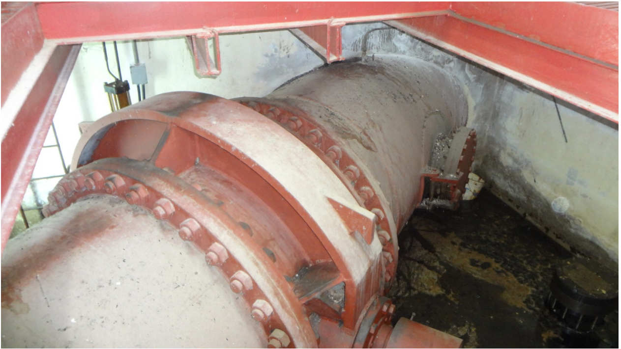
Figura 9.- Interno locale biforcazione esistente, piano interrato
