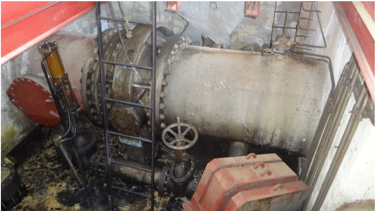
Figura 8.- Interno locale biforcazione esistente, piano interrato
