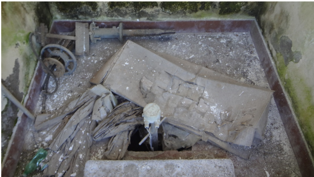
Figura 11.- Interno locale misurazione esistente.
