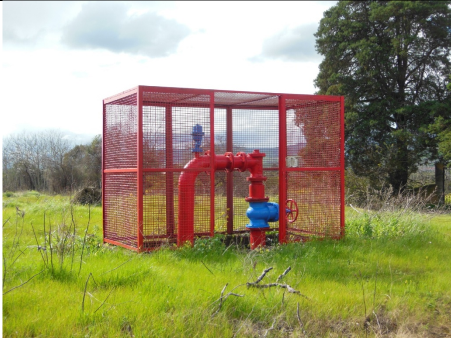
Figura 1- Cabina di presa principale da dismettere e demolire
