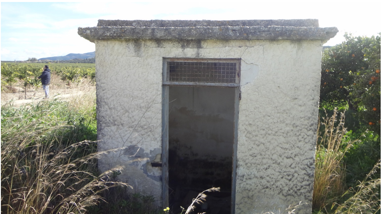
Figura 10.- Esterno locale misurazione esistente.
