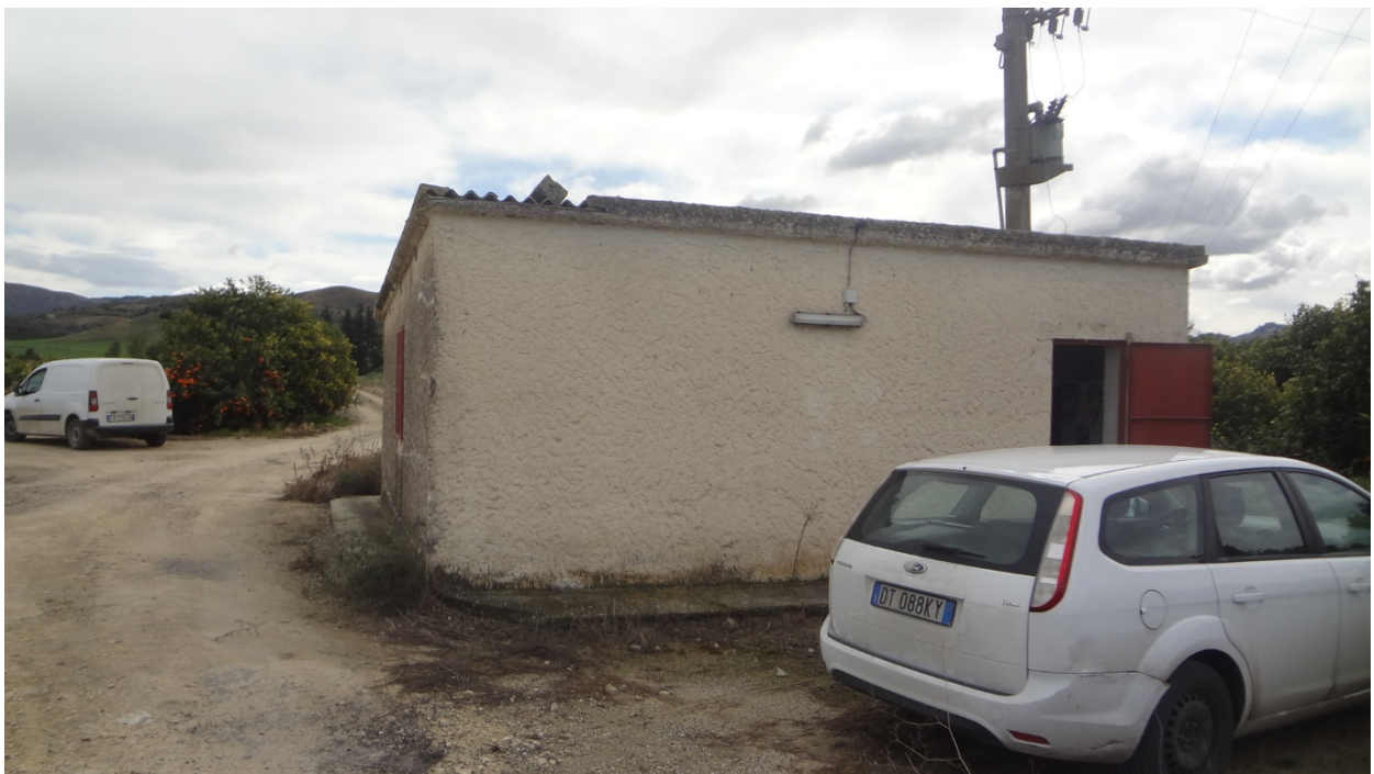
Figura 6.- Esterni locale biforcazione esistente.
